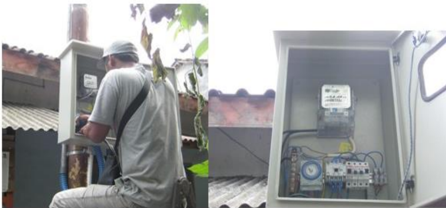
Gambar 7. Pemasangan KWH Meter
